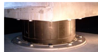
免震構造の採用により大地震の揺れを減衰
