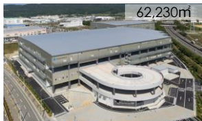
プロロジスパーク神戸2 (兵庫県神戸市)
