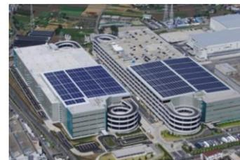
外壁に断熱性・水密性に優れた断熱サンドイッチパネルを採用
