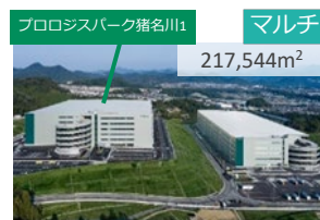
プロロジスパーク猪名川1 (兵庫県川辺郡) 2021年11月竣工
