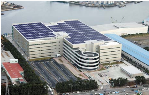
プロロジスパーク市川1（千葉県市川市）
