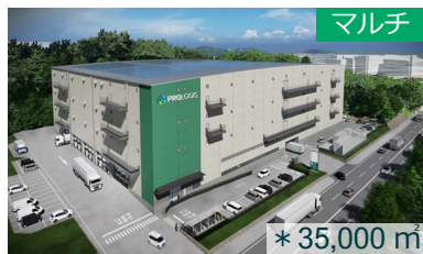
● プロロジスパーク岡山 (岡山市) 2025年8月竣工予定
