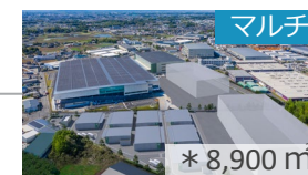
● プロロジスパーク古河6 (茨城県古河市) 2024年12月竣工予定
