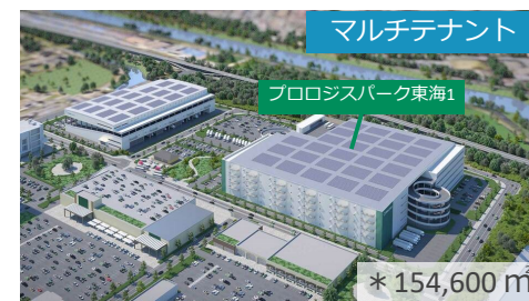
マルチテナント プロロジスパーク東海1 (愛知県東海市)
