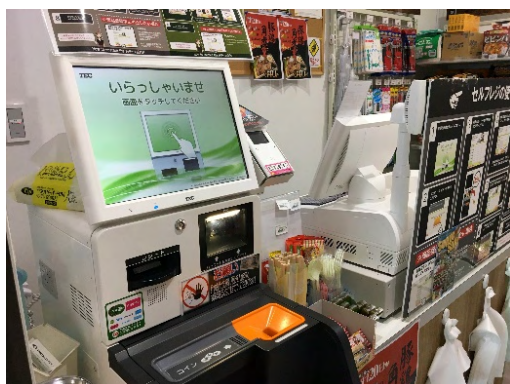
コンビニエンスストアにセルフレジを設置 (プロロジスパーク市川3)
