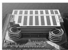
日本全国で屋根を活用した大規模な太陽光発電システムの導入等の取り組み実施
