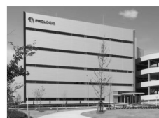
施設外壁には断熱サンドイッチパネルを、施設屋根には断熱二重折板材を採用し、断熱性の高いより良い館内環境を提供
