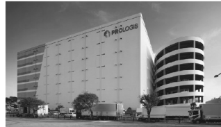
プロロジスパーク東京大田の共用棟の 新設及び外壁のリニューアル
