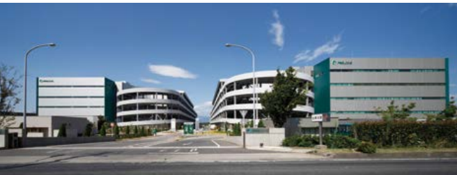
M-02 プロロジスパーク座間1 M-10 プロロジスパーク座間2
