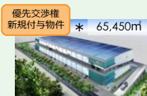
プロロジスパーク習志野5 (千葉県習志野市) 2016年3月竣工予定
