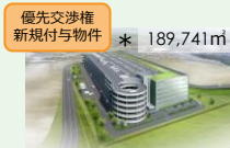
プロロジスパーク茨木 (大阪府茨木市) 2016年9月竣工予定
