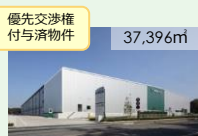
プロロジスパーク常総 (茨城県常総市)
