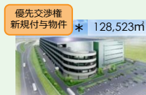
プロロジスパーク千葉ニュータウン (千葉県印西市) 2016年5月竣工予定
