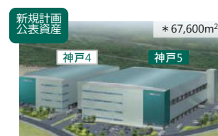
プロロジスパーク神戸4・5 (兵庫県神戸市)
