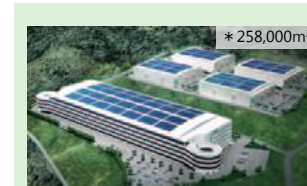
プロロジス猪名川プロジェクト (兵庫県川辺郡)
