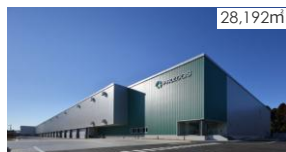
プロロジスパーク成田1-D マルチテナント型、2015年1月竣工 (千葉県成田市)
