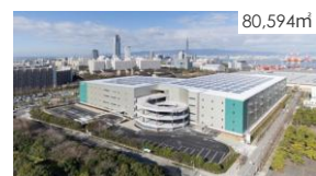
プロロジスパーク大阪5 マルチテナント型、2015年1月竣工 (大阪府大阪市)
