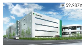
プロロジスパーク市川3 (千葉県市川市)
