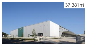
プロロジスパーク常総 マルチテナント型、2014年10月竣工 (茨城県常総市)
