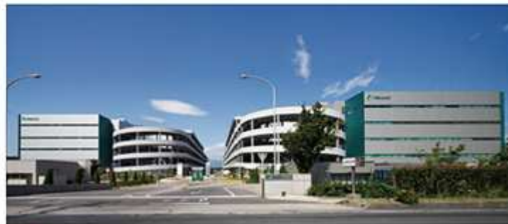
M-02 プロロジスパーク座間1 M-10 プロロジスパーク座間2
