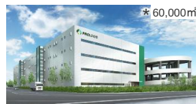
プロロジスパーク市川3(千葉県市川市)
