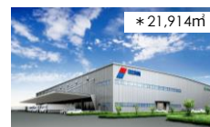
* 21,914㎡ プロロジスパーク古河2 (茨城県古河市) 2017年4月竣工予定
