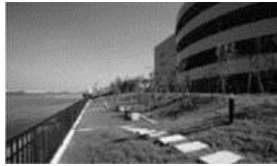
屋上や外壁、敷地内の積極的な 緑化を実施
