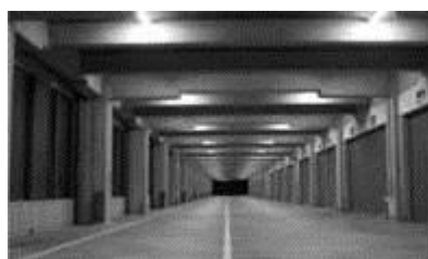
館内照明器具をLED化 温室効果ガス排出量削減を実現
